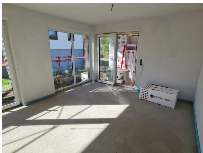
Wohnzimmer richtung Balkon
