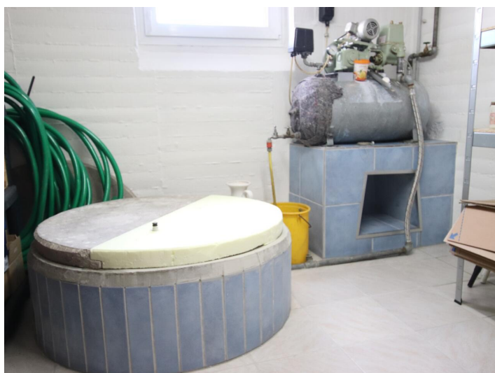
Saniertes tolles 105m 2 Einfamilienhaus in Viktring
