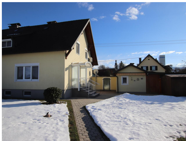
Saniertes tolles 105m 2 Einfamilienhaus in Viktring
