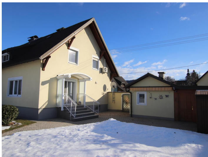
Saniertes tolles 105m 2 Einfamilienhaus in Viktring
