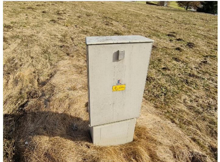
Sonniger, Baugrund an der Golfanlage Moosburg
