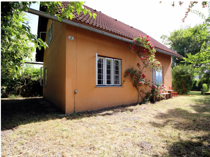
Ansicht Haus Süd/West
