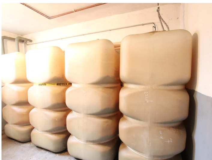
150m² Einfamilienwohnhaus in Klagenfurt
