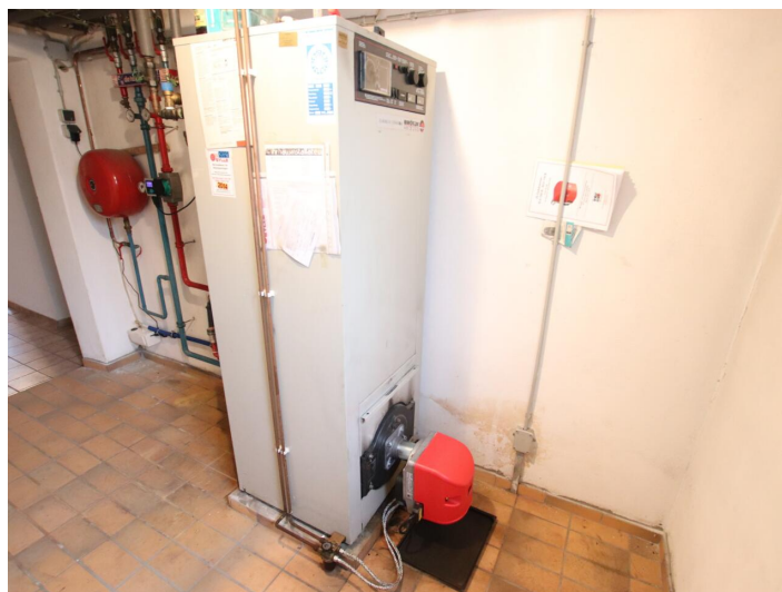
150m² Einfamilienwohnhaus in Klagenfurt
