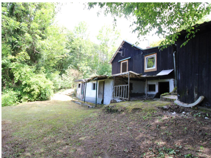
Viktring, Abrisshaus in Ruhelage!
