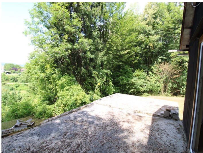
Viktring, Abrisshaus in Ruhelage!
