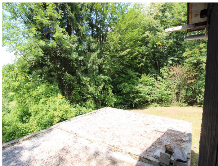
Viktring, Abrisshaus in Ruhelage!
