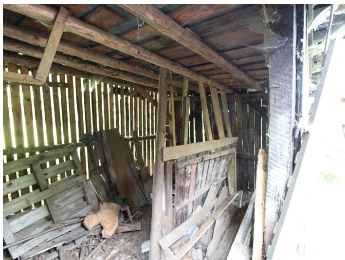
Viktring, Abrisshaus in Ruhelage!
