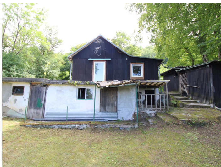
Viktring, Abrisshaus in Ruhelage!
