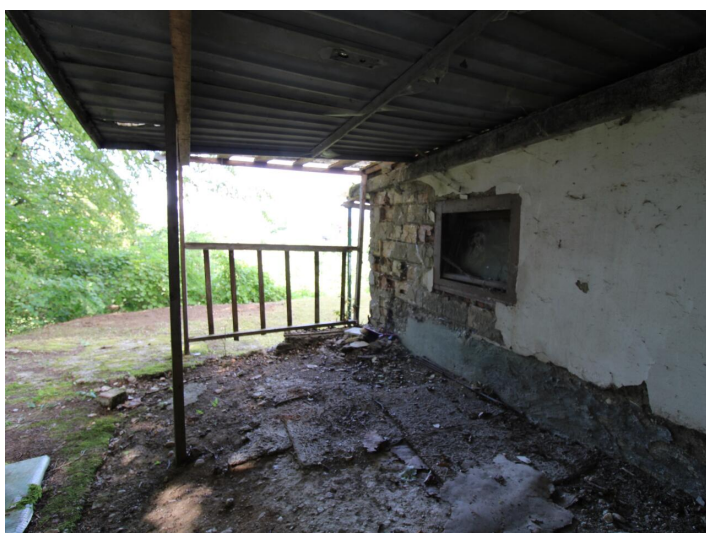
Viktring, Abrisshaus in Ruhelage!
