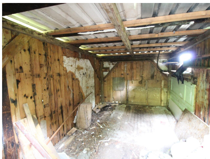
Viktring, Abrisshaus in Ruhelage!
