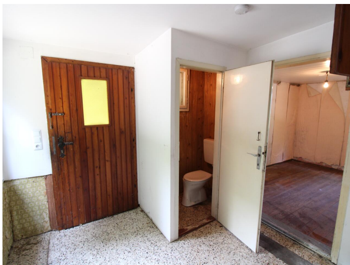
Viktring, Abrisshaus in Ruhelage!
