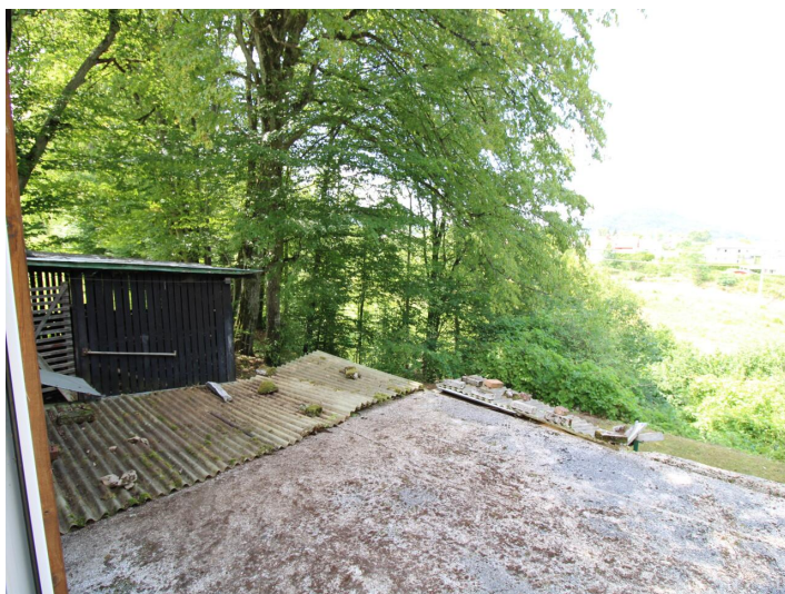
Viktring, Abrisshaus in Ruhelage!
