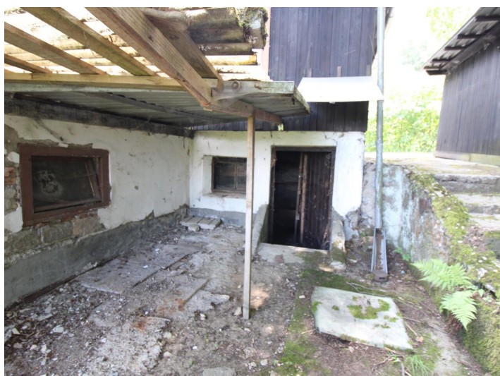
Viktring, Abrisshaus in Ruhelage!
