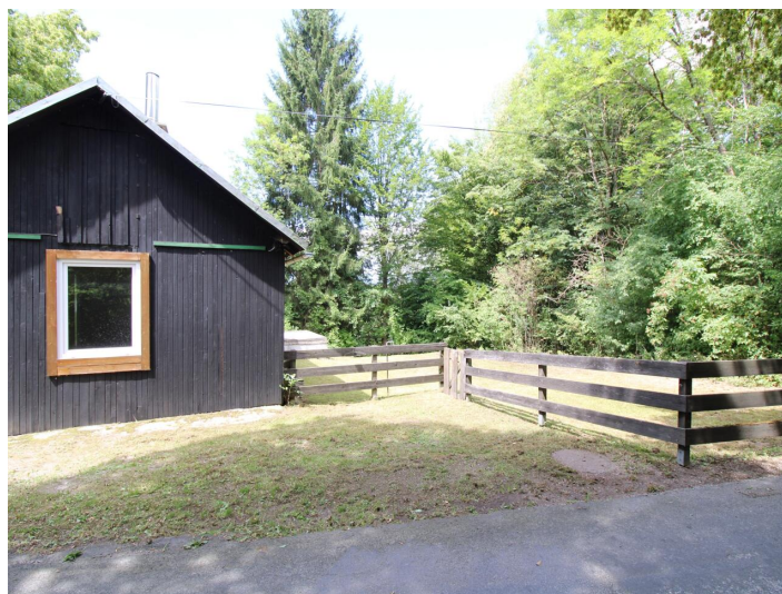
Viktring, Abrisshaus in Ruhelage!
