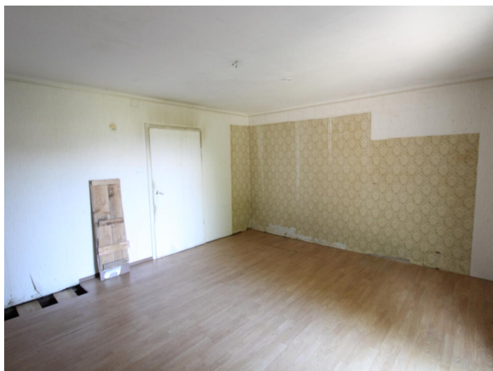
Viktring, Abrisshaus in Ruhelage!
