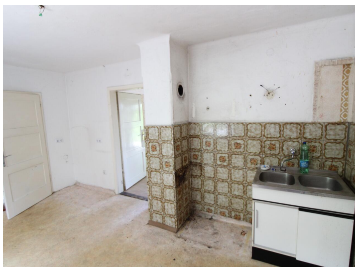
Viktring, Abrisshaus in Ruhelage!
