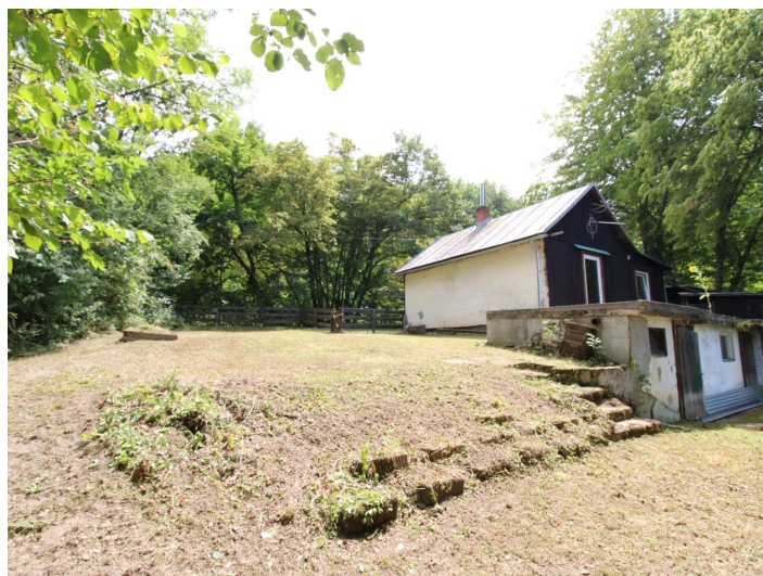
Viktring, Abrisshaus in Ruhelage!
