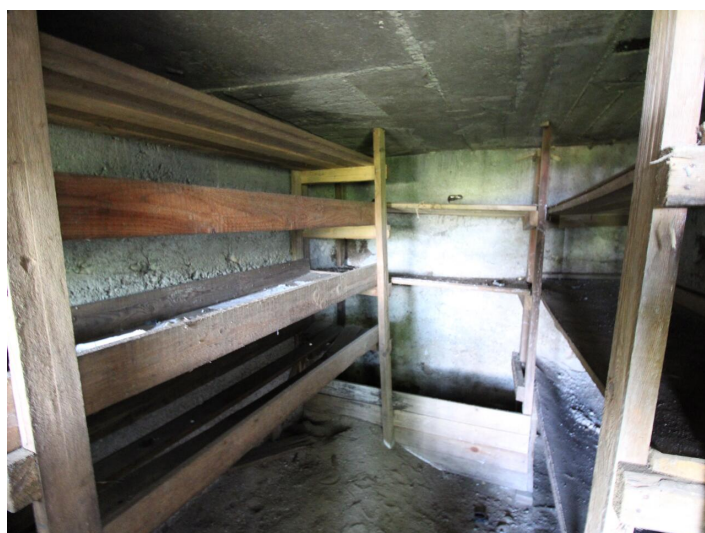
Viktring, Abrisshaus in Ruhelage!
