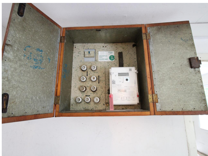
Viktring, Abrisshaus in Ruhelage!
