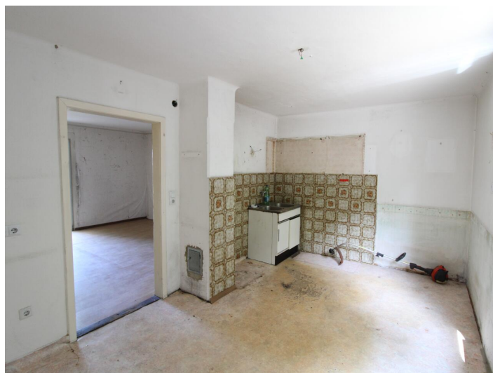
Viktring, Abrisshaus in Ruhelage!
