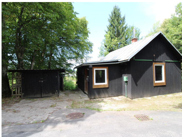
Viktring, Abrisshaus in Ruhelage!
