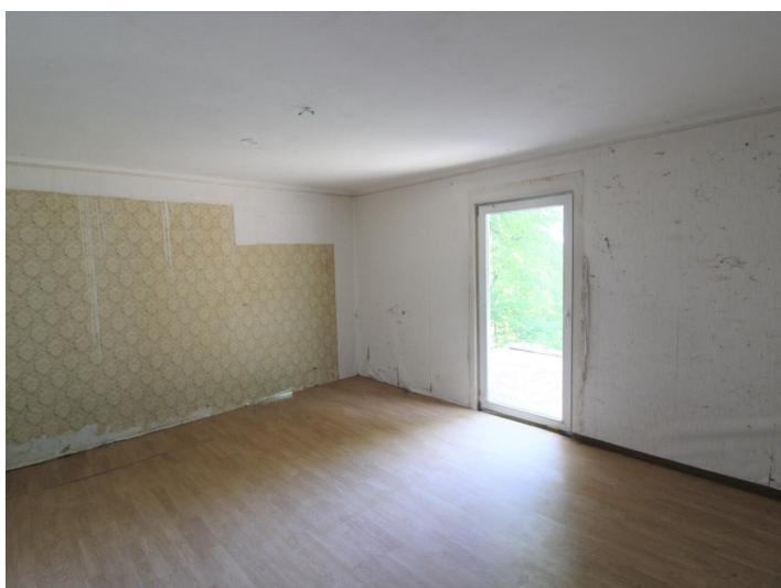
Viktring, Abrisshaus in Ruhelage!
