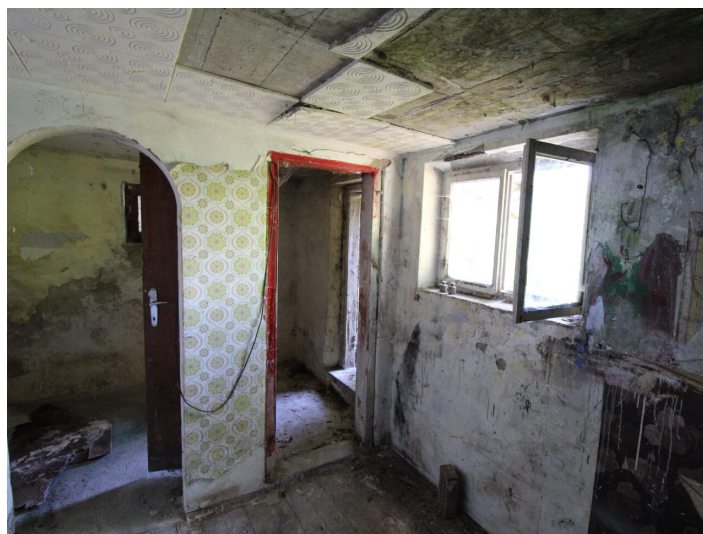
Viktring, Abrisshaus in Ruhelage!
