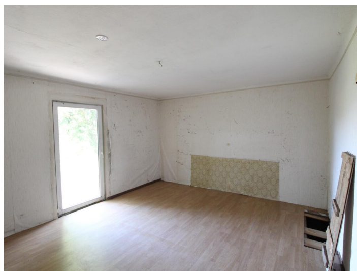
Viktring, Abrisshaus in Ruhelage!
