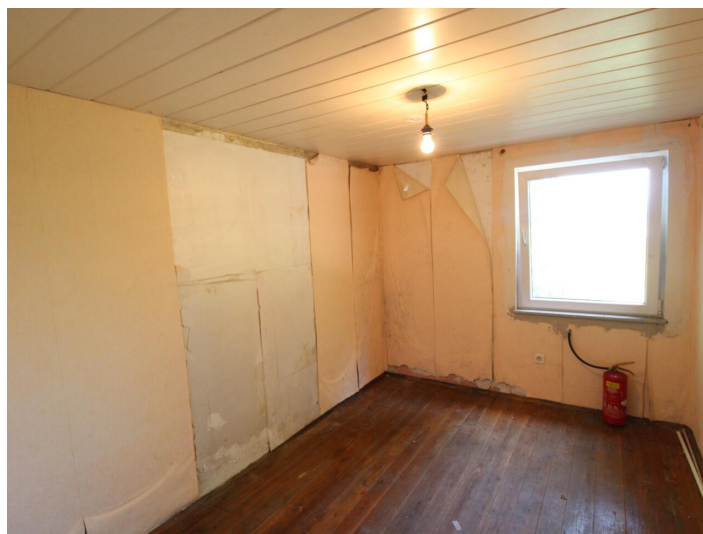
Viktring, Abrisshaus in Ruhelage!
