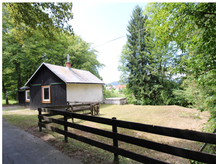
Viktring, Abrisshaus in Ruhelage!
