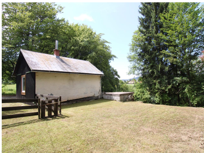
Viktring, Abrisshaus in Ruhelage!
