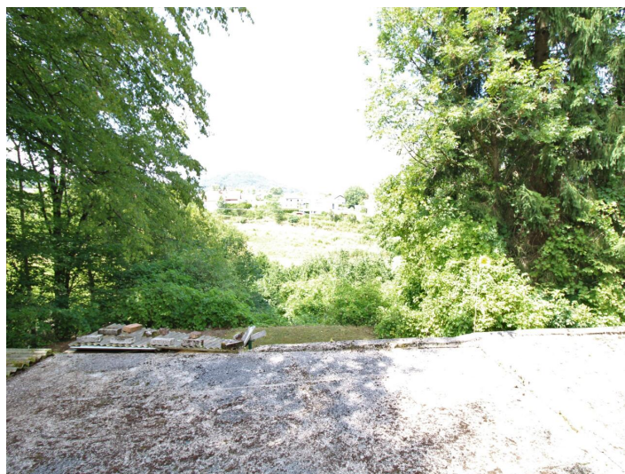
Viktring, Abrisshaus in Ruhelage!
