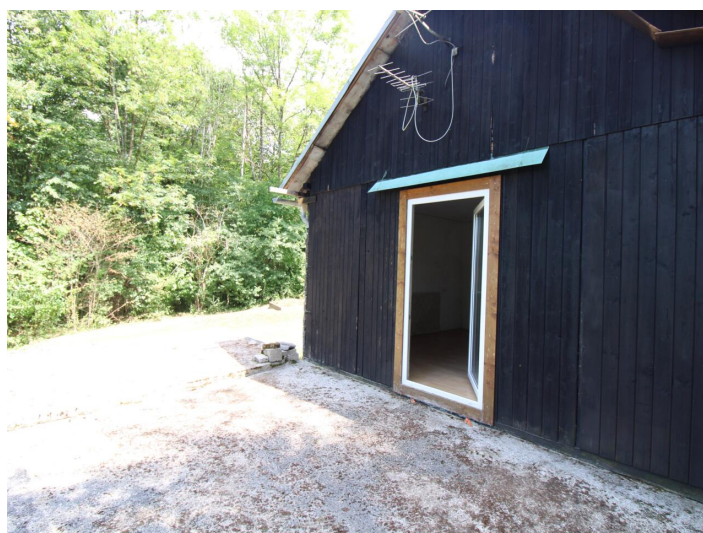
Viktring, Abrisshaus in Ruhelage!
