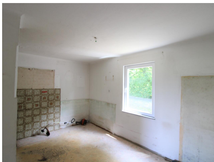
Viktring, Abrisshaus in Ruhelage!
