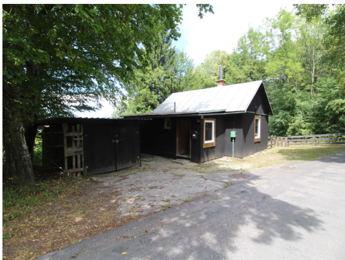
Viktring, Abrisshaus in Ruhelage!
