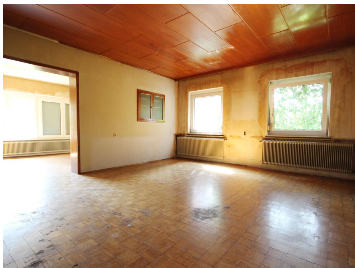
Wohnhaus/Sanierungsbedürftig in bester Lage
