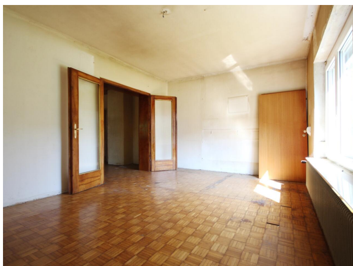
Wohnhaus/Sanierungsbedürftig in bester Lage
