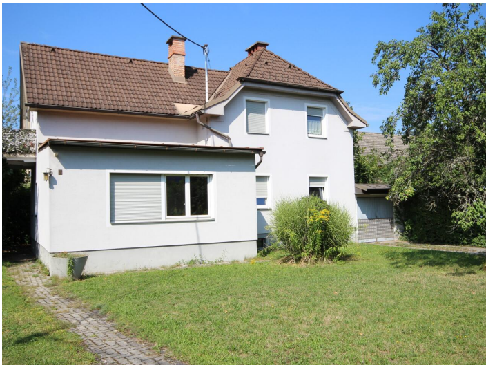
Wohnhaus/Sanierungsbedürftig in bester Lage
