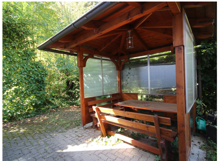
Wohnhaus/Sanierungsbedürftig in bester Lage
