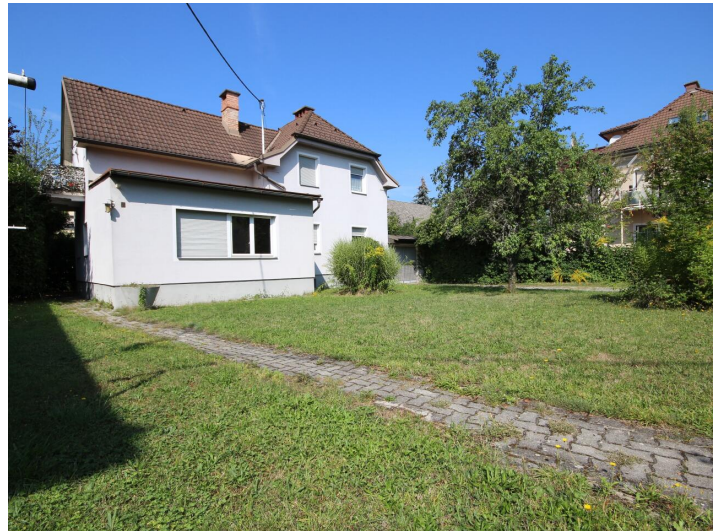
Wohnhaus/Sanierungsbedürftig in bester Lage
