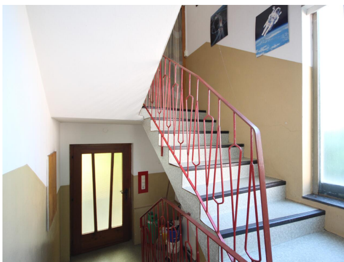
Wohnhaus/Sanierungsbedürftig in bester Lage
