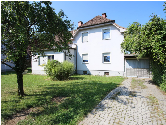
Wohnhaus/Sanierungsbedürftig in bester Lage
