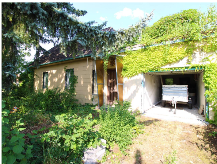
Baugrundstück in Gerasdorf
