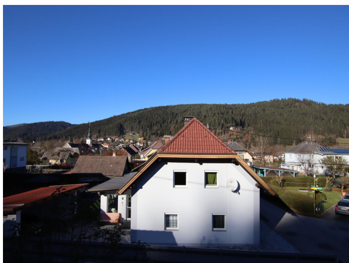
Schönes saniertes 120m 2 Wohnhaus im Gurktal - Weitensfeld
