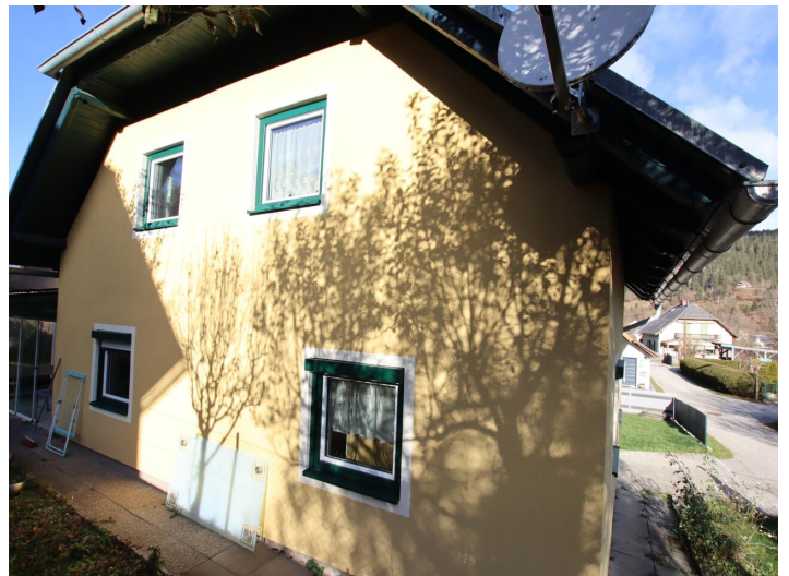
Schönes saniertes 120m 2 Wohnhaus im Gurktal - Weitensfeld
