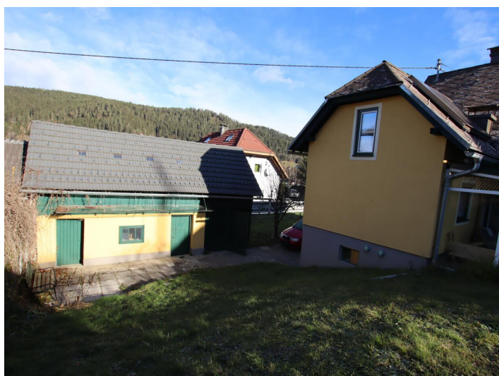
Schönes saniertes 120m 2 Wohnhaus im Gurktal - Weitensfeld
