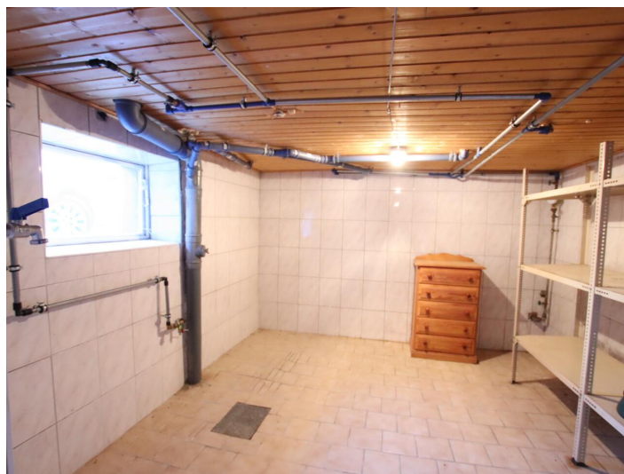
Schönes saniertes 120m 2 Wohnhaus im Gurktal - Weitensfeld
