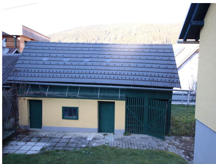
Schönes saniertes 120m 2 Wohnhaus im Gurktal - Weitensfeld
