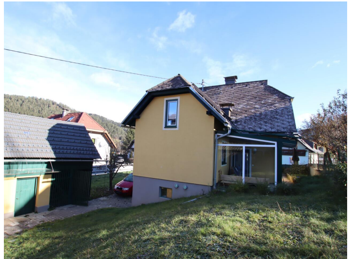
Schönes saniertes 120m 2 Wohnhaus im Gurktal - Weitensfeld
