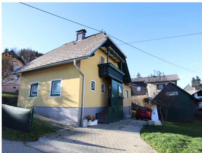
Schönes saniertes 120m 2 Wohnhaus im Gurktal - Weitensfeld
