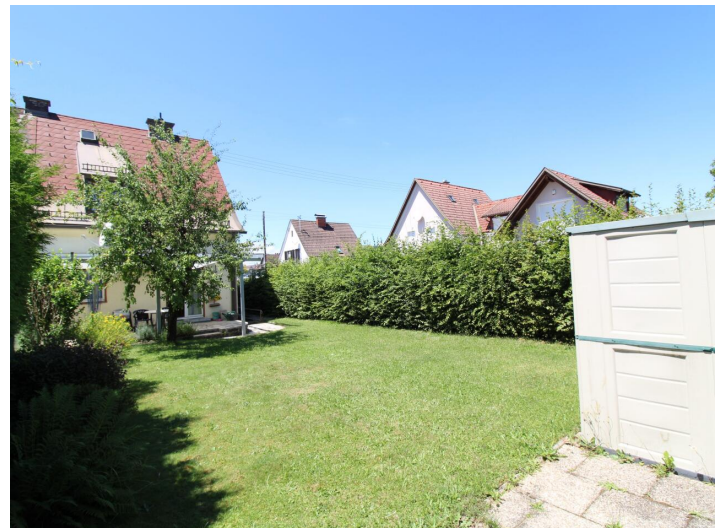
Teilsaniertes 88m 2 Wohnhaus in Waidmannsdorf - Top Lage
