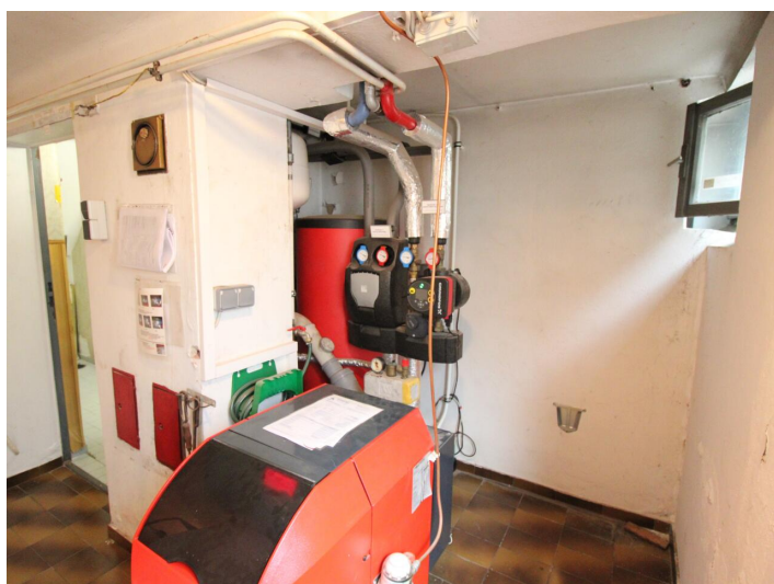
Teilsaniertes Wohnhaus in Waidmannsdorf ca. 88m 2
