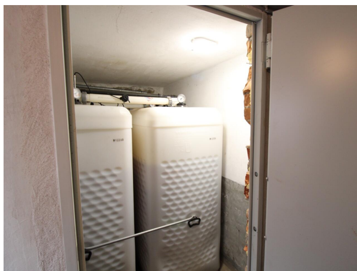
Teilsaniertes Wohnhaus in Waidmannsdorf ca. 88m 2
