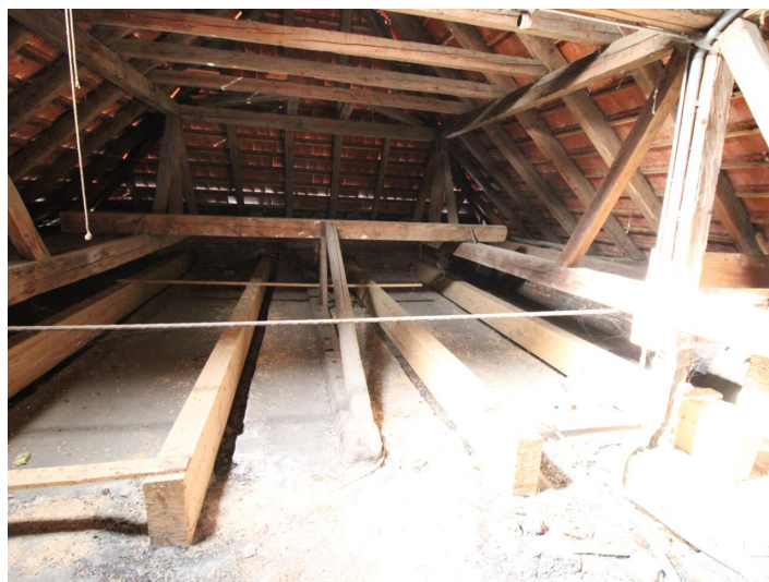
Historisches Gebäude - Bergrichterhaus Hüttenberg
