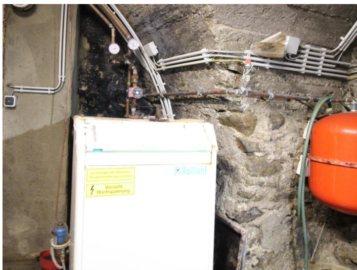
Historisches Gebäude - Bergrichterhaus Hüttenberg
