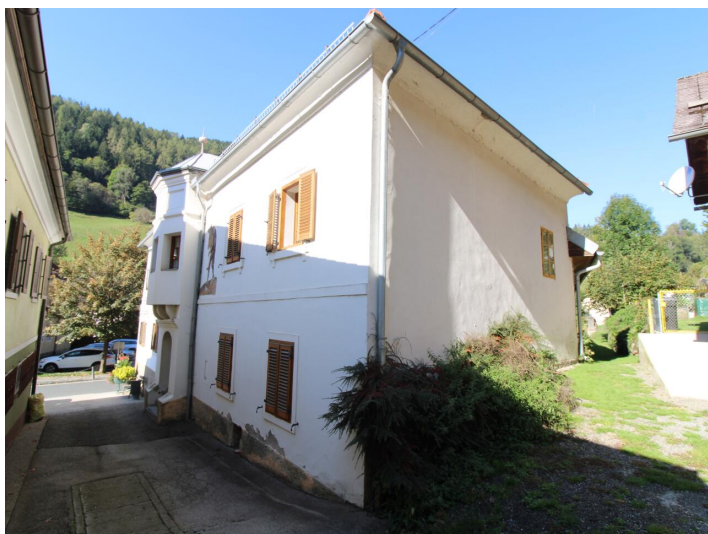
Historisches Gebäude - Bergrichterhaus Hüttenberg
