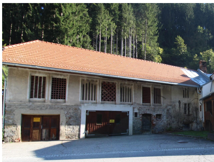
Historisches Gebäude - Bergrichterhaus Hüttenberg
