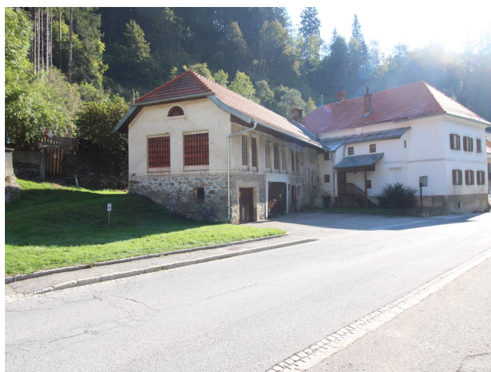
Historisches Gebäude - Bergrichterhaus Hüttenberg
