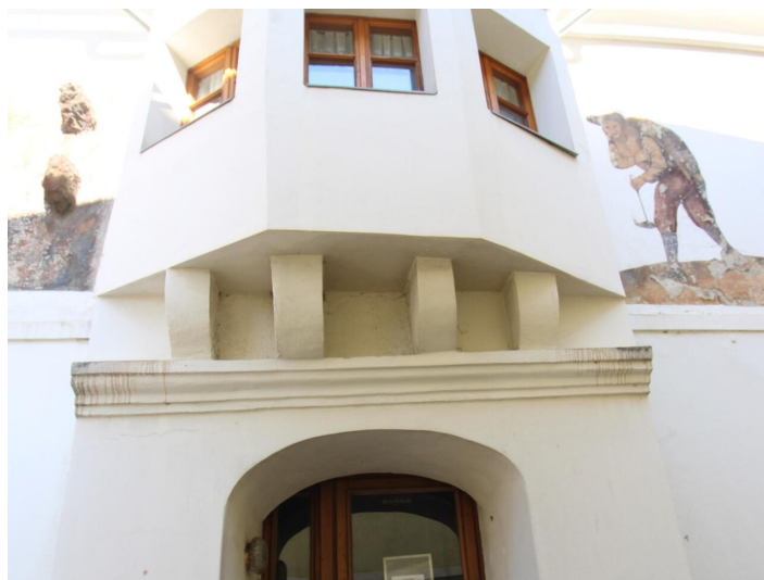
Historisches Gebäude - Bergrichterhaus Hüttenberg
