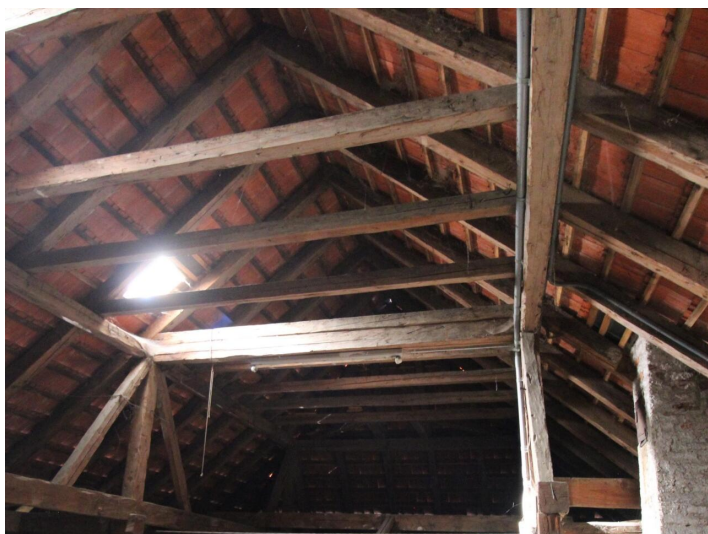
Historisches Gebäude - Bergrichterhaus Hüttenberg
