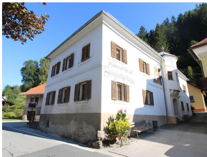
Historisches Gebäude - Bergrichterhaus Hüttenberg
