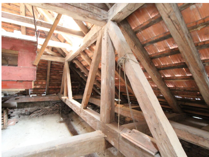
Historisches Gebäude - Bergrichterhaus Hüttenberg
