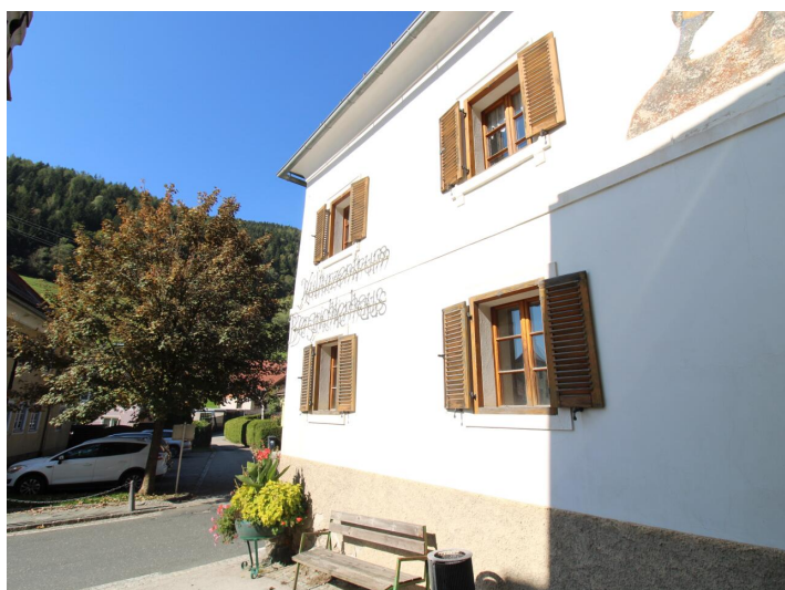
Historisches Gebäude - Bergrichterhaus Hüttenberg
