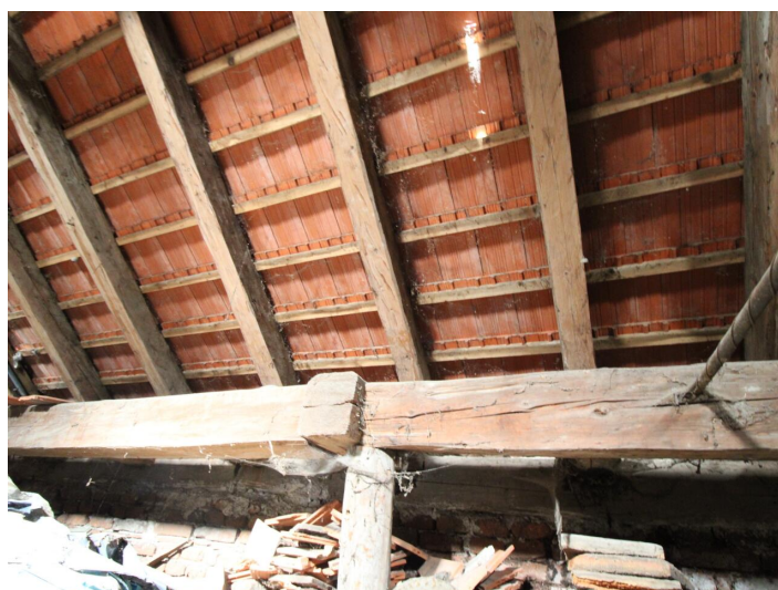
Historisches Gebäude - Bergrichterhaus Hüttenberg
