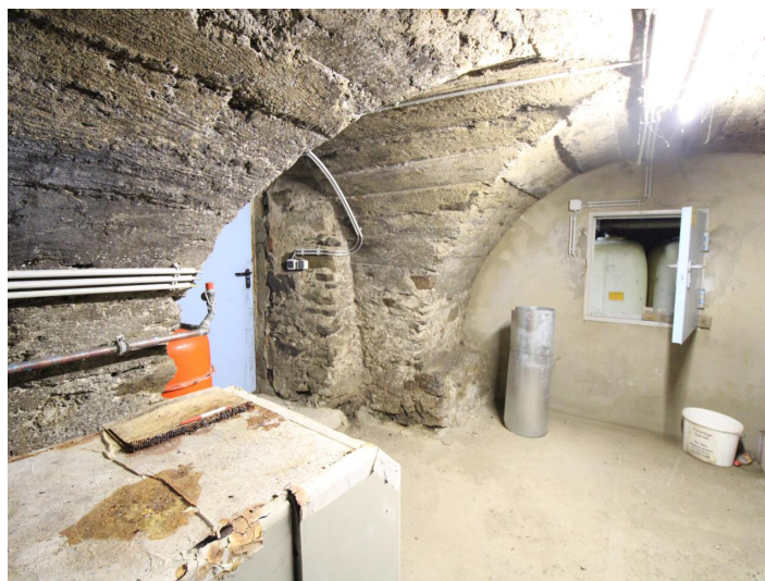
Historisches Gebäude - Bergrichterhaus Hüttenberg
