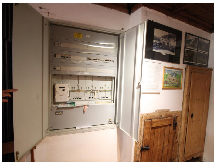
Historisches Gebäude - Bergrichterhaus Hüttenberg
