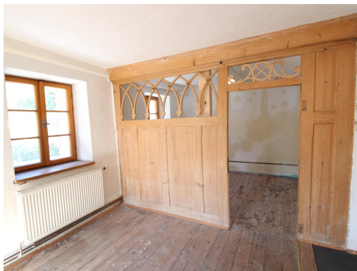
Historisches Gebäude - Bergrichterhaus Hüttenberg
