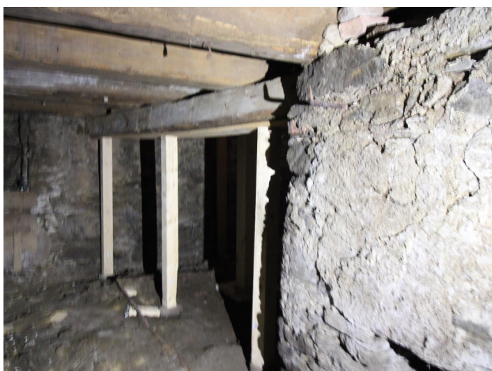
Historisches Gebäude - Bergrichterhaus Hüttenberg
