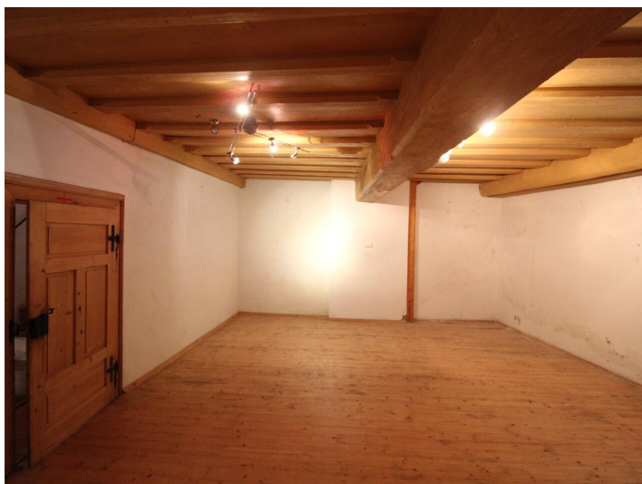
Historisches Gebäude - Bergrichterhaus Hüttenberg
