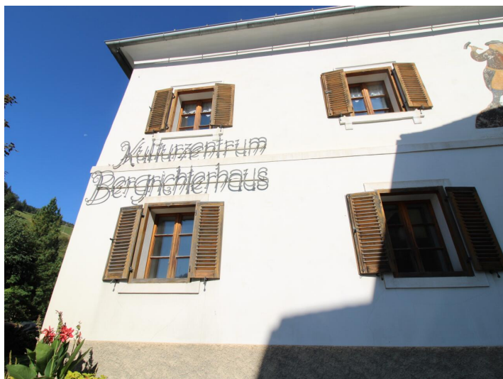
Historisches Gebäude - Bergrichterhaus Hüttenberg
