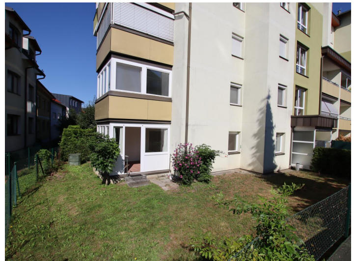
Junge & schöne 71,50m 2 2 Zi City-Gartenwohnung mit 123m 2 Eigengarten & Tiefgarage - St....
