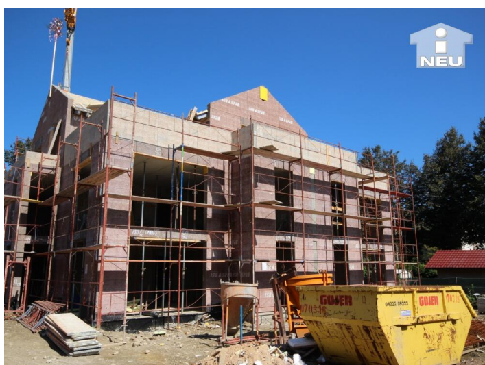
Rohnbau Fertigstellung geschafft
