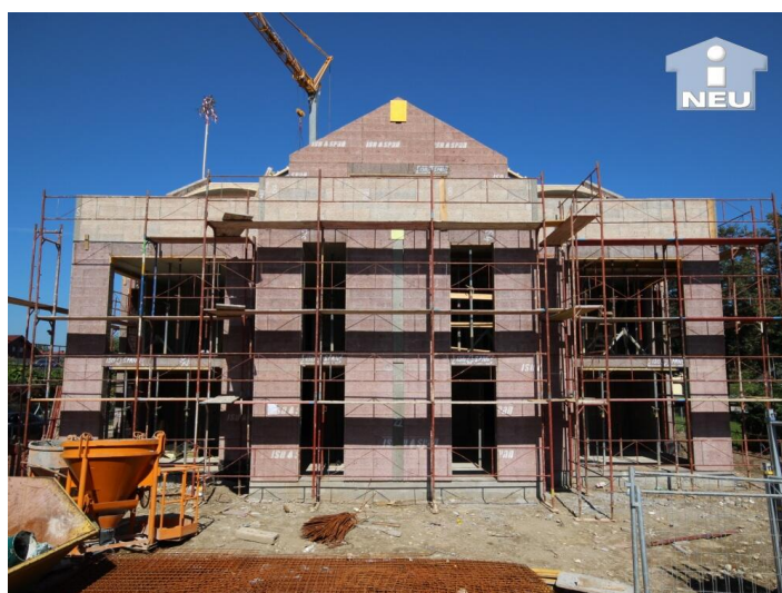
Rohnbau Fertigstellung geschafft
