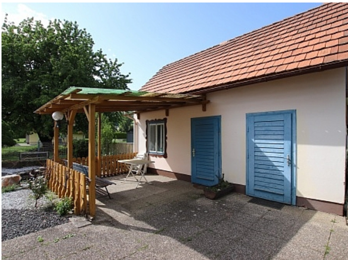
150m 2 Einfamilienhaus mit Nebengebäude - Wolfsberg
