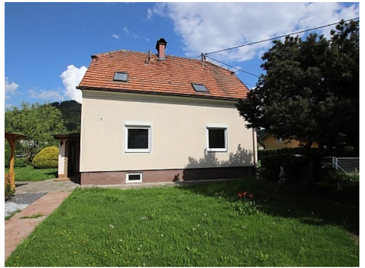
150m 2 Einfamilienhaus mit Nebengebäude - Wolfsberg
