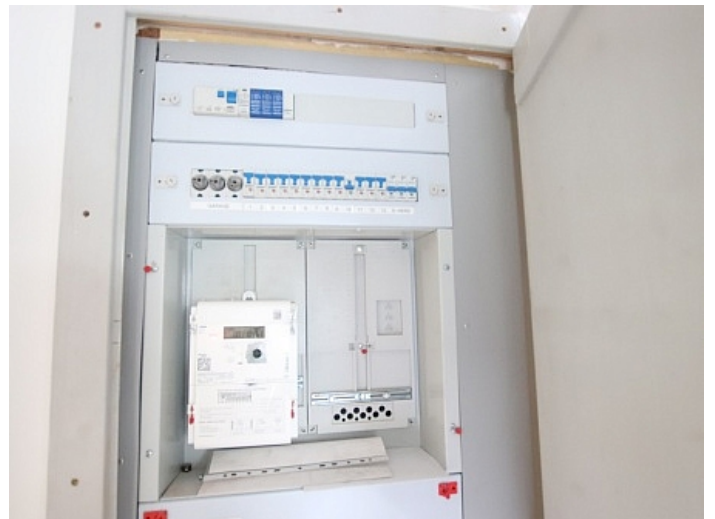
150m 2 Einfamilienhaus mit Nebengebäude - Wolfsberg
