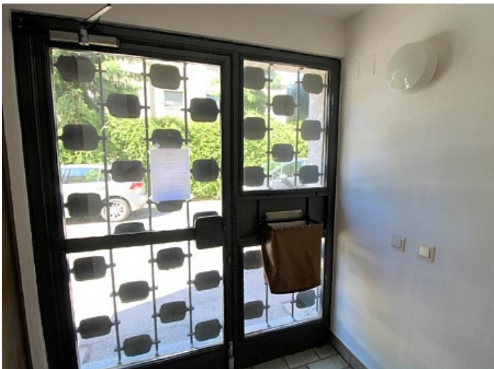
Ehemalige Praxis Mozartstrasse sanierungsbedürftig
