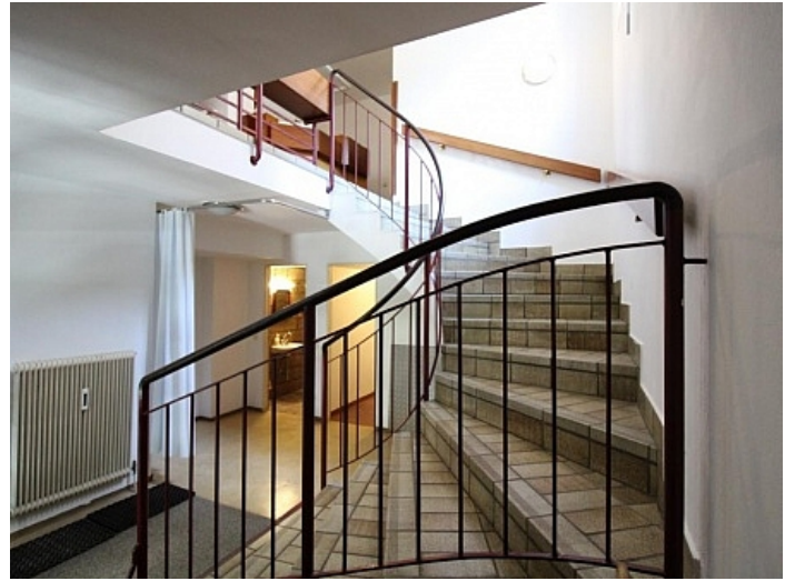
Ehemalige Praxis Mozartstrasse sanierungsbedürftig
