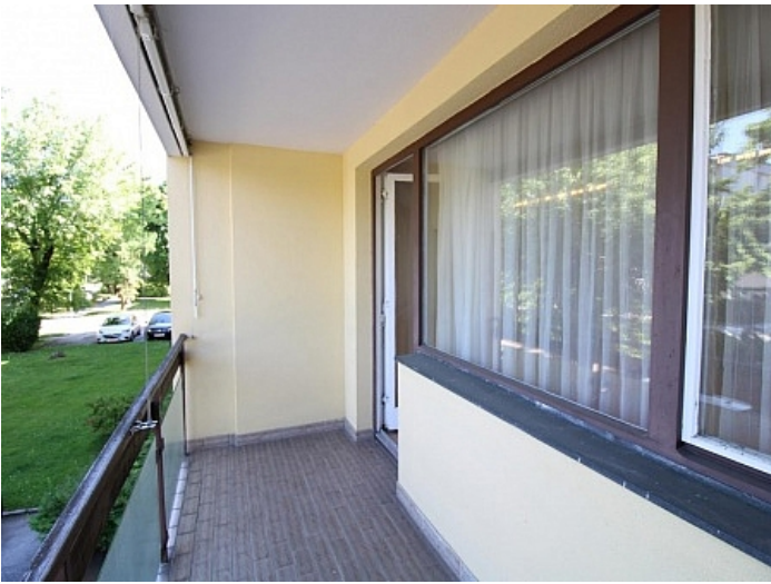
Ehemalige Praxis Mozartstrasse sanierungsbedürftig
