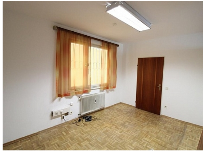
Ehemalige Praxis Mozartstrasse sanierungsbedürftig
