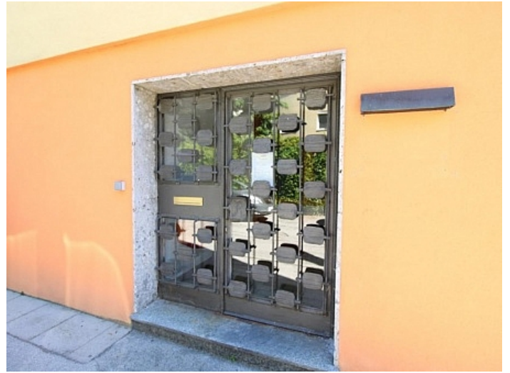
Ehemalige Praxis Mozartstrasse sanierungsbedürftig
