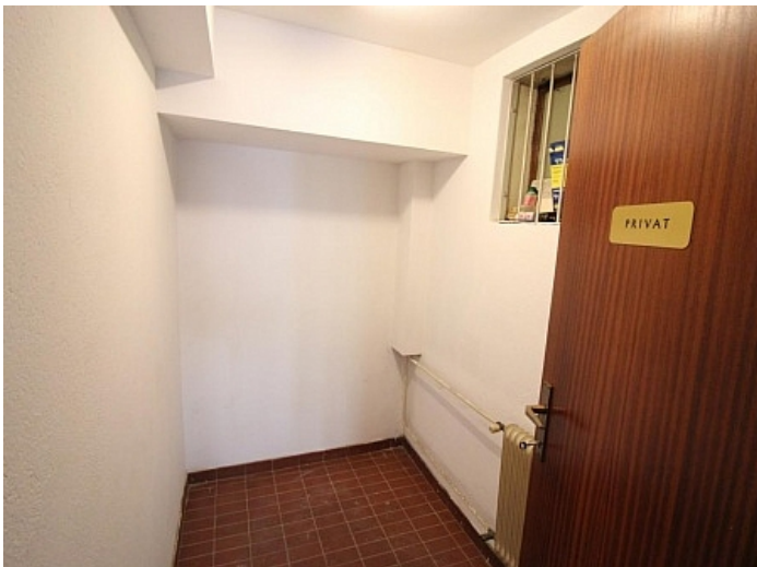
Ehemalige Praxis Mozartstrasse sanierungsbedürftig
