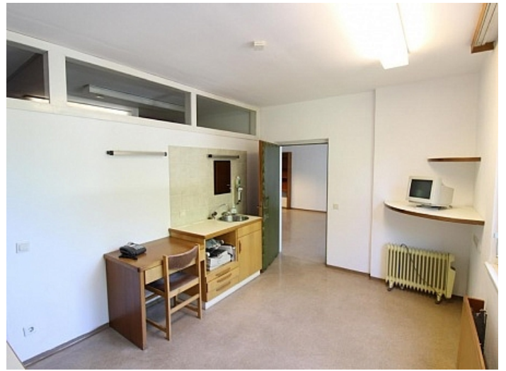
Ehemalige Praxis Mozartstrasse sanierungsbedürftig
