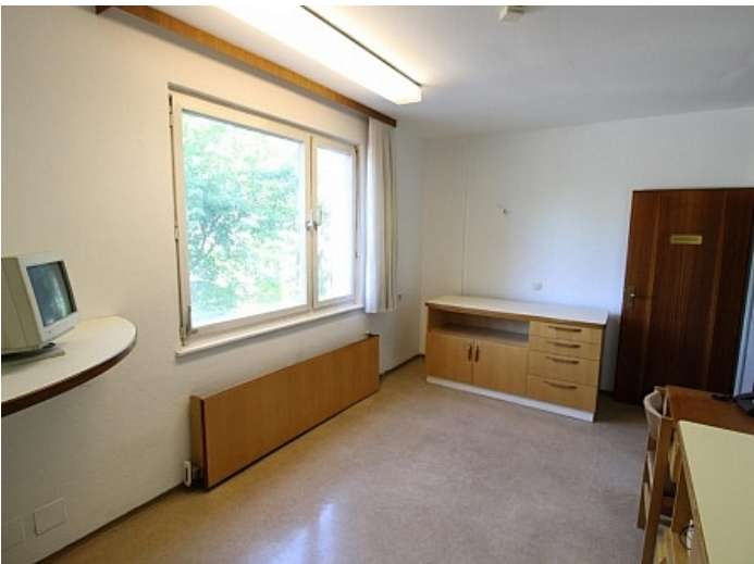
Ehemalige Praxis Mozartstrasse sanierungsbedürftig
