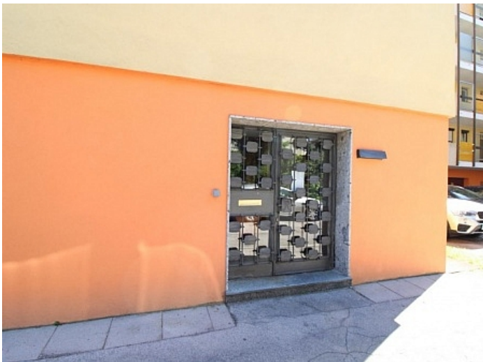
Ehemalige Praxis Mozartstrasse sanierungsbedürftig
