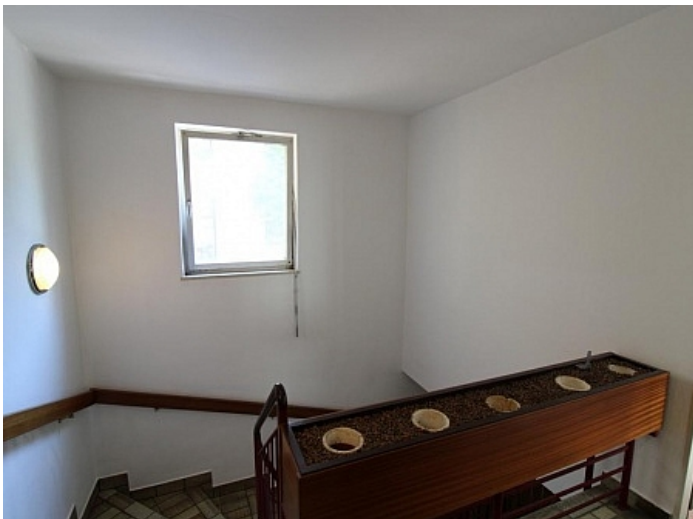
Ehemalige Praxis Mozartstrasse sanierungsbedürftig
