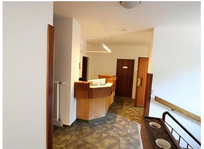
Ehemalige Praxis Mozartstrasse sanierungsbedürftig
