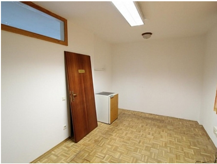
Ehemalige Praxis Mozartstrasse sanierungsbedürftig
