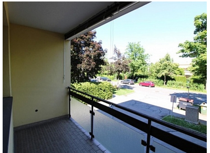
Ehemalige Praxis Mozartstrasse sanierungsbedürftig
