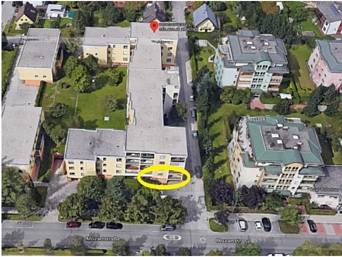
Ehemalige Praxis Mozartstrasse sanierungsbedürftig
