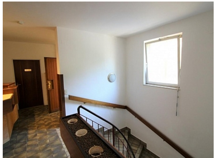
Ehemalige Praxis Mozartstrasse sanierungsbedürftig
