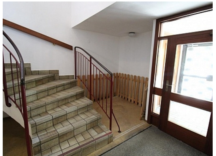
Ehemalige Praxis Mozartstrasse sanierungsbedürftig
