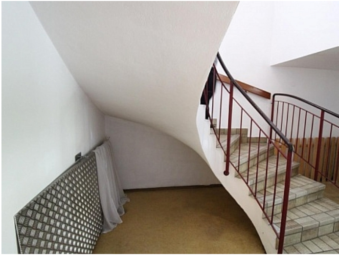
Ehemalige Praxis Mozartstrasse sanierungsbedürftig
