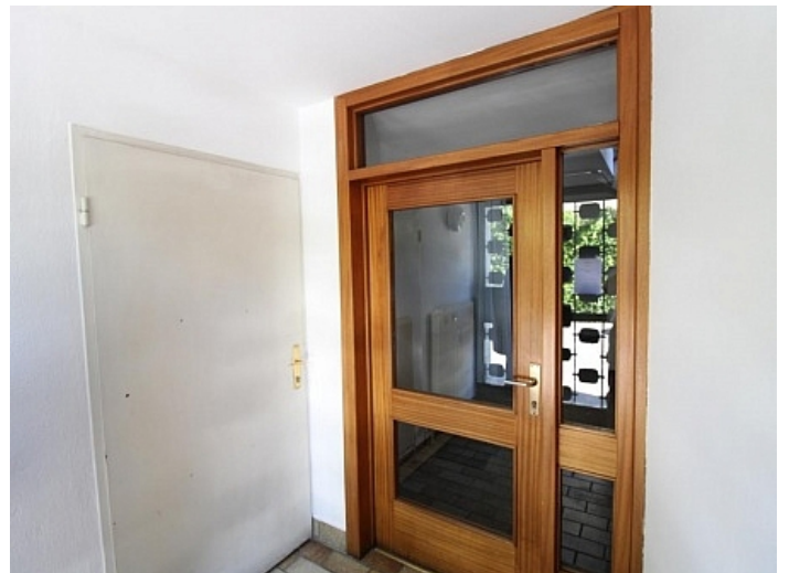
Ehemalige Praxis Mozartstrasse sanierungsbedürftig
