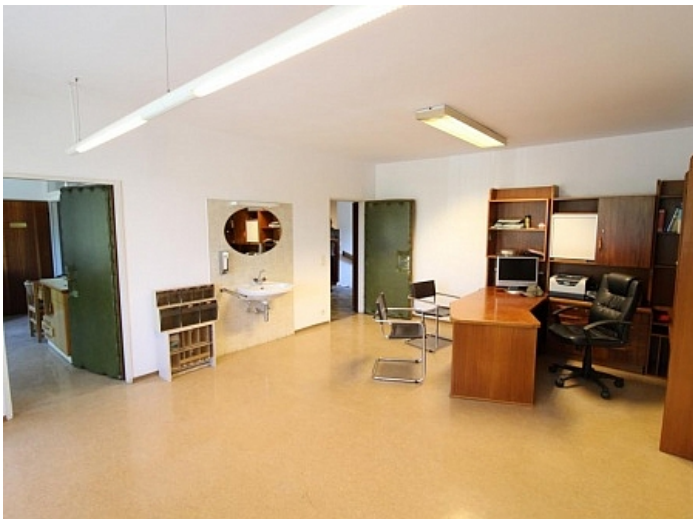
Ehemalige Praxis Mozartstrasse sanierungsbedürftig
