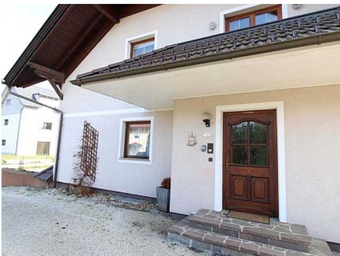
Exclusive Villa bzw. Pension in Reifnitz nur 300 Meter vom See
