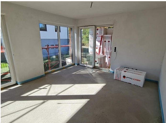
Wohnzimmer richtung Balkon
