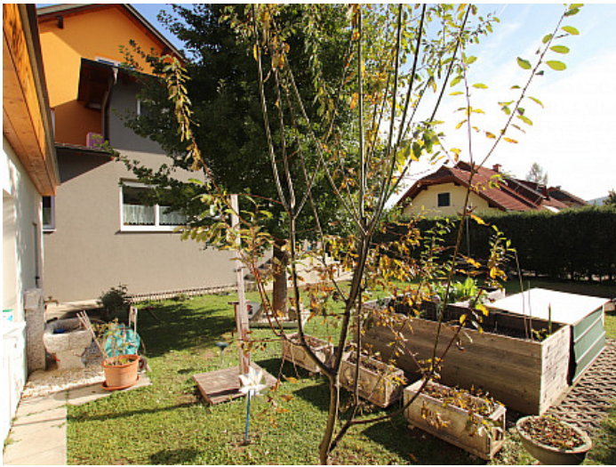
Schönes saniertes 230m 2 Wohnhaus in Krobathen
