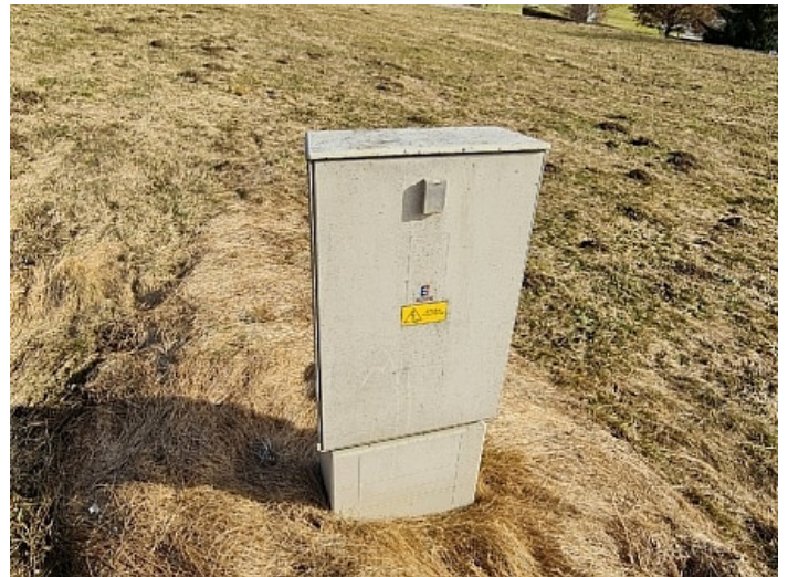
Sonniger, Baugrund an der Golfanlage Moosburg
