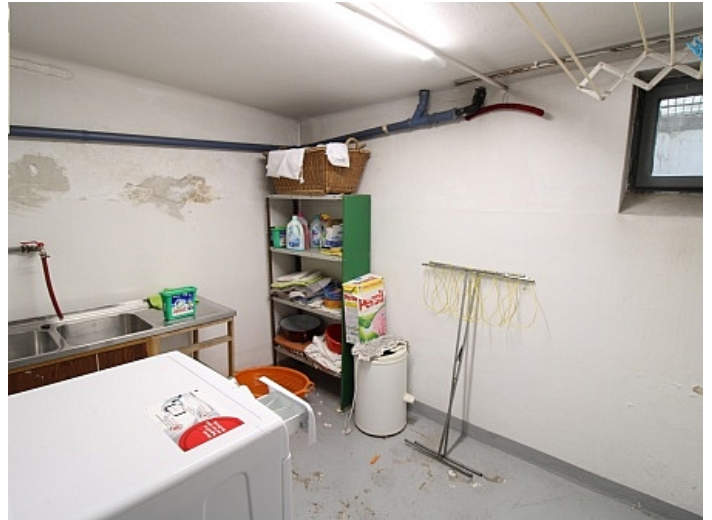
Teilsaniertes Wohnhaus in Waidmannsdorf ca. 88m 2
