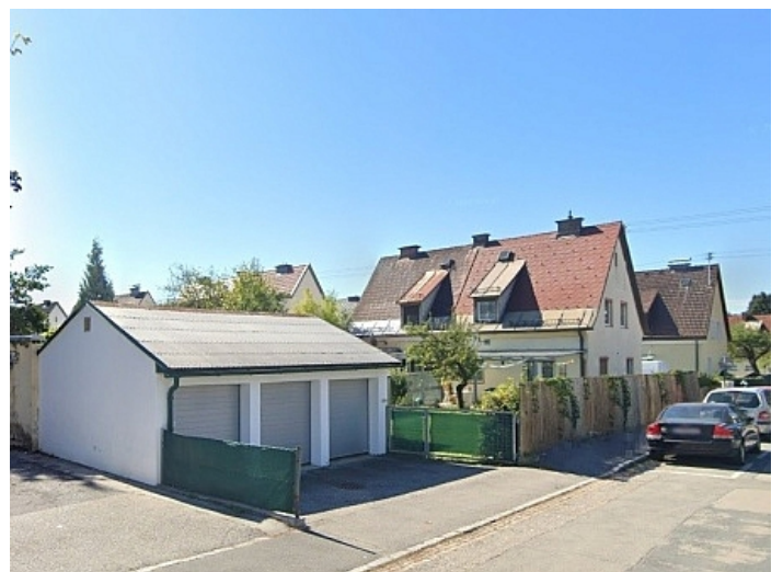
Teilsaniertes Wohnhaus in Waidmannsdorf ca. 88m 2
