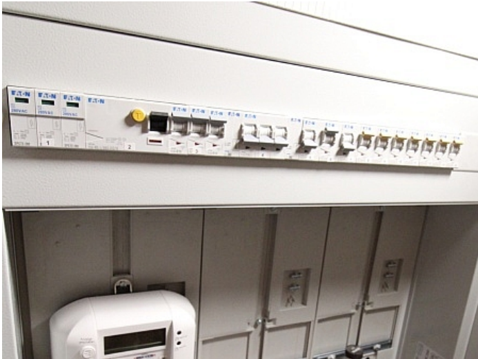
Teilsaniertes Wohnhaus in Waidmannsdorf ca. 88m 2
