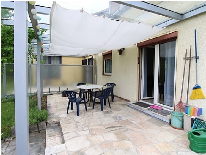
Teilsaniertes Wohnhaus in Waidmannsdorf ca. 88m 2
