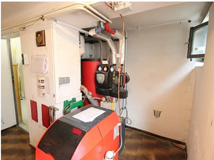
Teilsaniertes Wohnhaus in Waidmannsdorf ca. 88m 2
