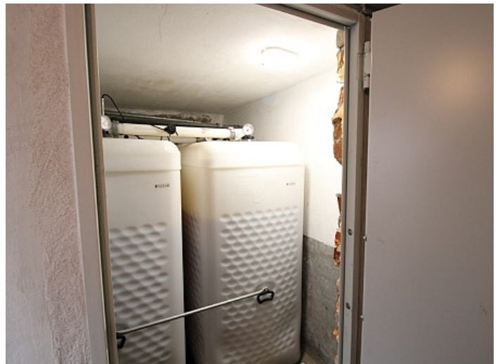
Teilsaniertes Wohnhaus in Waidmannsdorf ca. 88m 2
