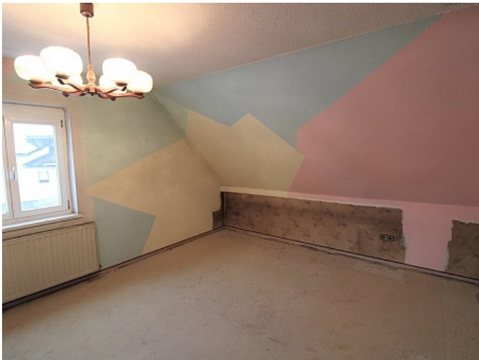
Teilsaniertes Wohnhaus in Ferlach ca. 90m 2
