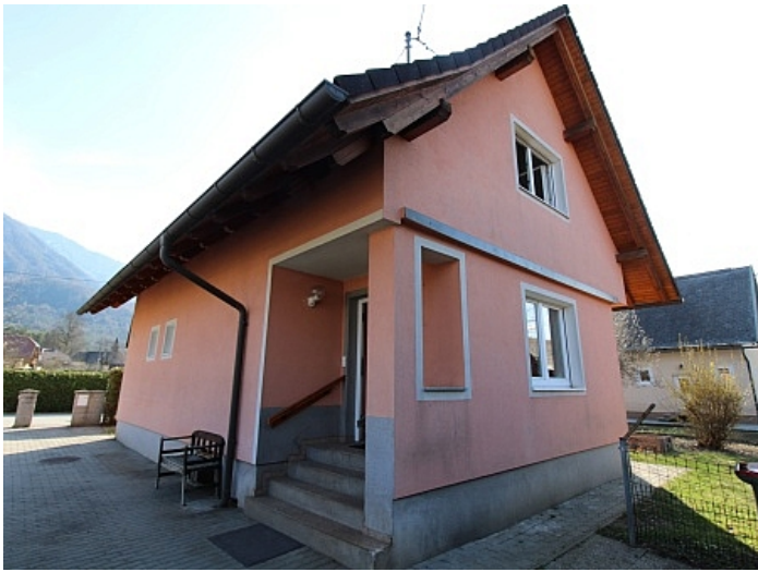
Teilsaniertes Wohnhaus in Ferlach ca. 90m 2
