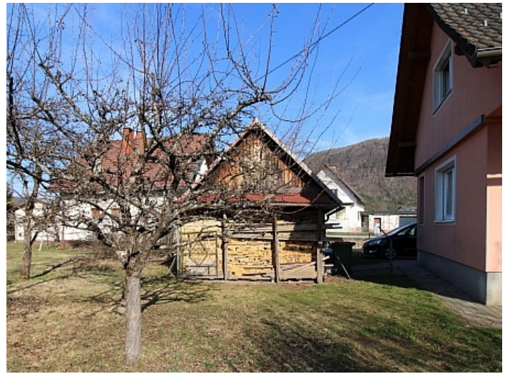
Teilsaniertes Wohnhaus in Ferlach ca. 90m 2
