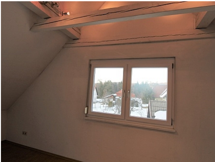
Teilsaniertes Wohnhaus in Ferlach ca. 90m 2
