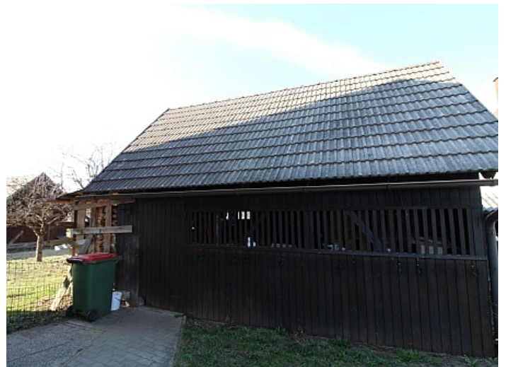
Teilsaniertes Wohnhaus in Ferlach ca. 90m 2
