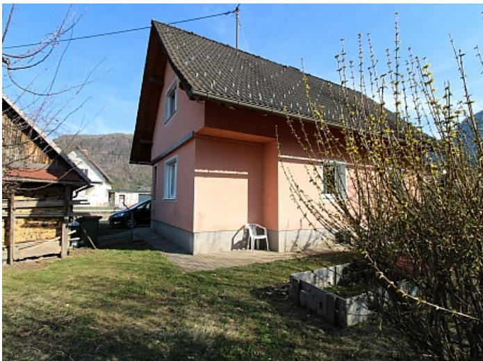
Teilsaniertes Wohnhaus in Ferlach ca. 90m 2
