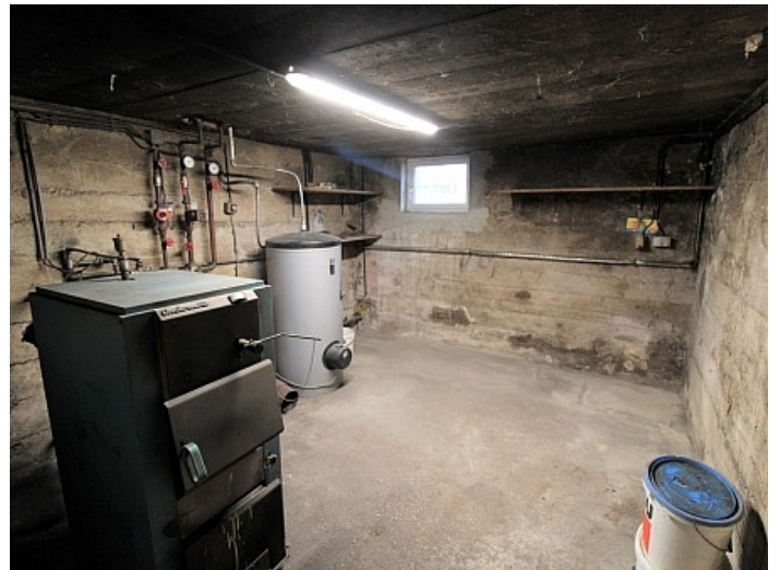
Teilsaniertes Wohnhaus in Ferlach ca. 90m 2
