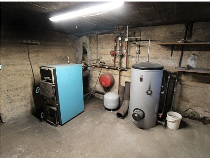
Teilsaniertes Wohnhaus in Ferlach ca. 90m 2
