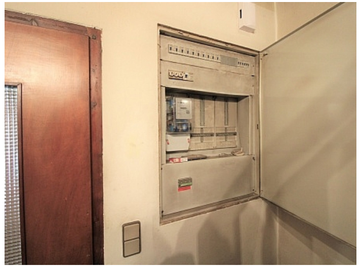
Teilsaniertes Wohnhaus in Ferlach ca. 90m 2
