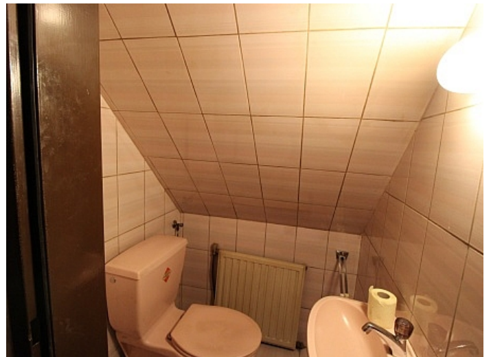
Teilsaniertes Wohnhaus in Ferlach ca. 90m 2
