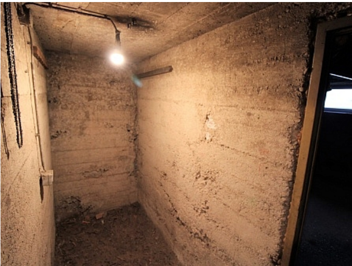
Teilsaniertes Wohnhaus in Ferlach ca. 90m 2
