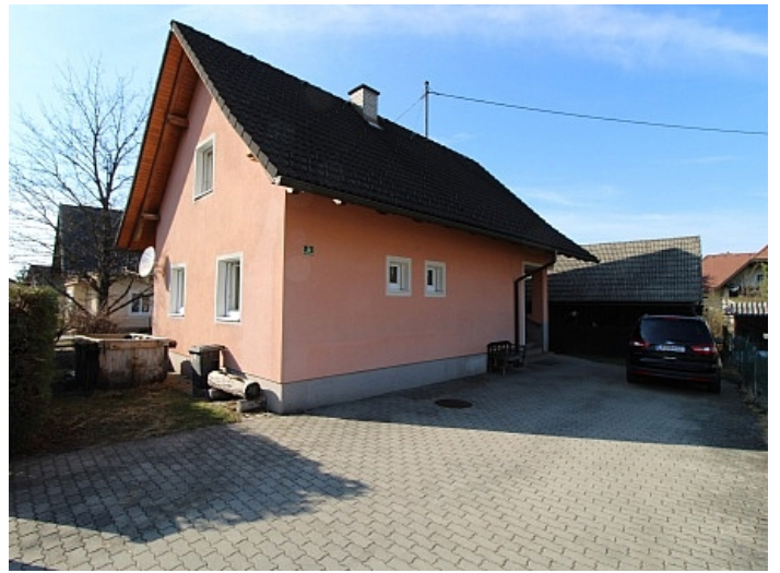
Teilsaniertes Wohnhaus in Ferlach ca. 90m 2
