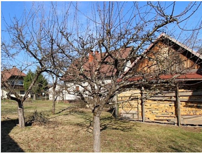
Teilsaniertes Wohnhaus in Ferlach ca. 90m 2
