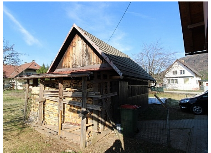
Teilsaniertes Wohnhaus in Ferlach ca. 90m 2
