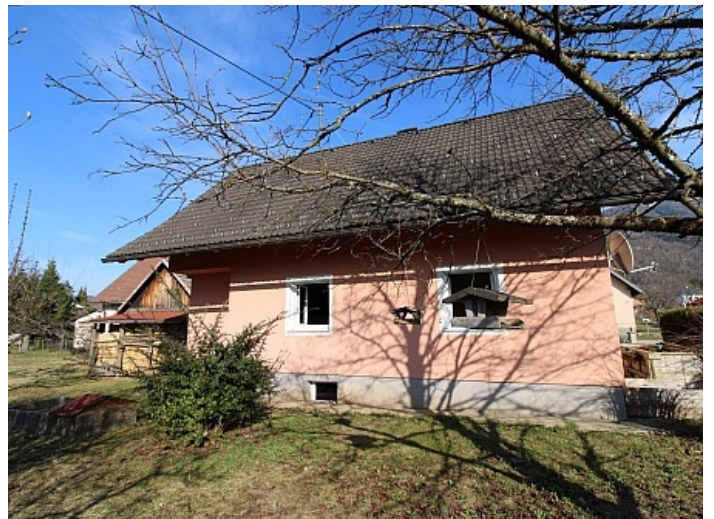
Teilsaniertes Wohnhaus in Ferlach ca. 90m 2
