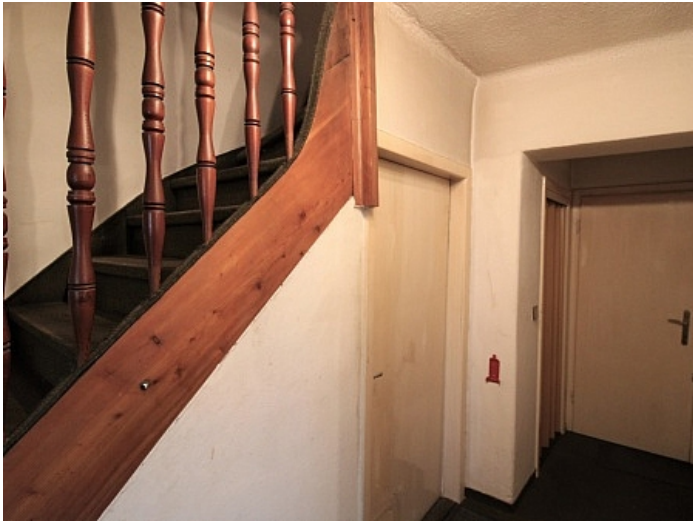
Teilsaniertes Wohnhaus in Ferlach ca. 90m 2
